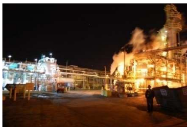
Figura 11: Luminosidad con sistemas LED (izquierda de la imagen) v/s sistema tradicional (derecha)
